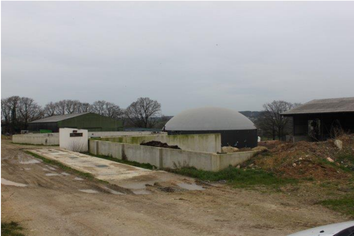
Un méthanisateur d'une puissance de 610 kW.
