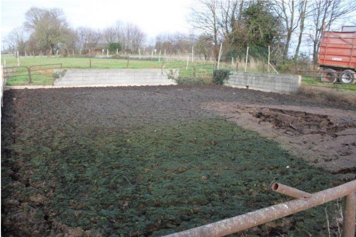
Le digestat obtenu est stocké dans cette cuve avant épandage.
